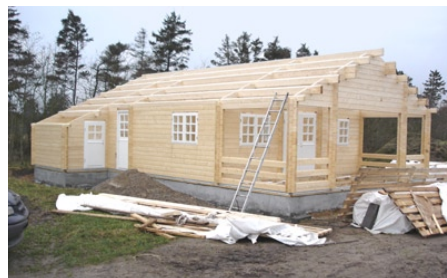
Huset klar til tagbrædder
