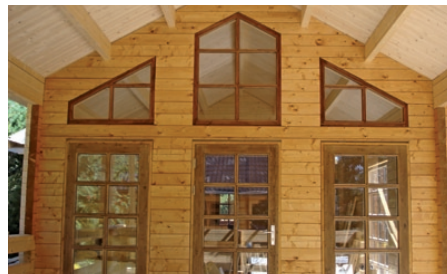
Montage af V/D efter opsætning
